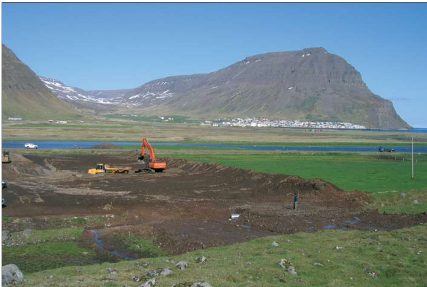
Bolungarvíkurgöng Bolungarvíkurmegin þar sem byrjað er að taka ofan af veglínu skammt fyrir utan gangamunna. Mynd: Björn A. Harðarson
