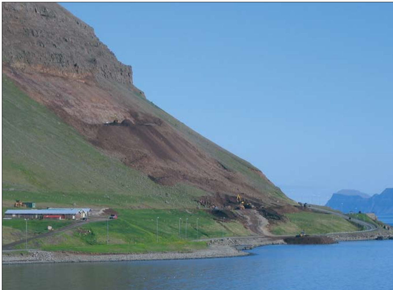
Bolungarvíkurgöng. Óvenjulegar aðstæður við gangamunna í Hnífsdal þar sem hreinsað er ofan af klöpp frá klettabeltum í um 130 m y.s. og niður að gangamunna en veghæð verður þar um 23 m y.s. Magn af lausu efni sem þarf að fjarlægja er áætlað um 140.000 m 3 . Mynd: Björn A. Harðarson
