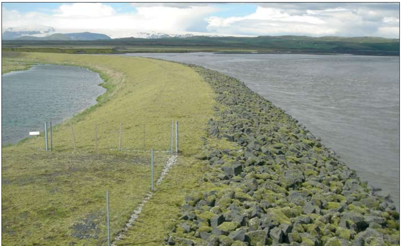
Varnargarður ofan og vestan brúar á Hringvegi yfir Kúðafljót. Mosi er einkennisjurt þessa svæðis eins og þekkt er á mosavöxnu Eldhrauni austan brúarinnar. Varnargarðarnir voru byggðir árið 1993 og á þeim 15 árum sem síðan eru liðin hefur mosinn nánast þakið varnargarðinn. Mynd: Helgi Jóhannesson
